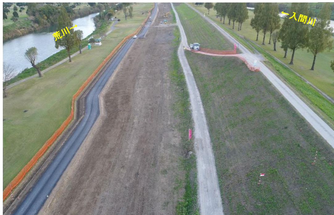
着手前（上流側から下流側へ撮影）
