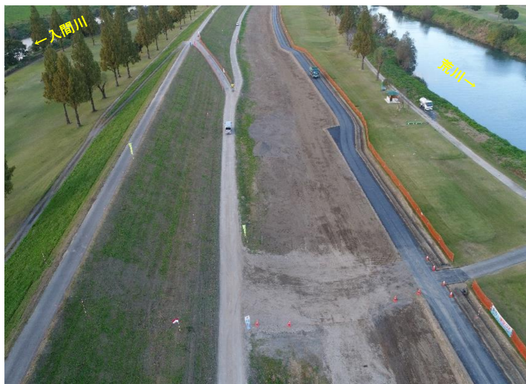
着手前（下流側から上流側へ撮影）
