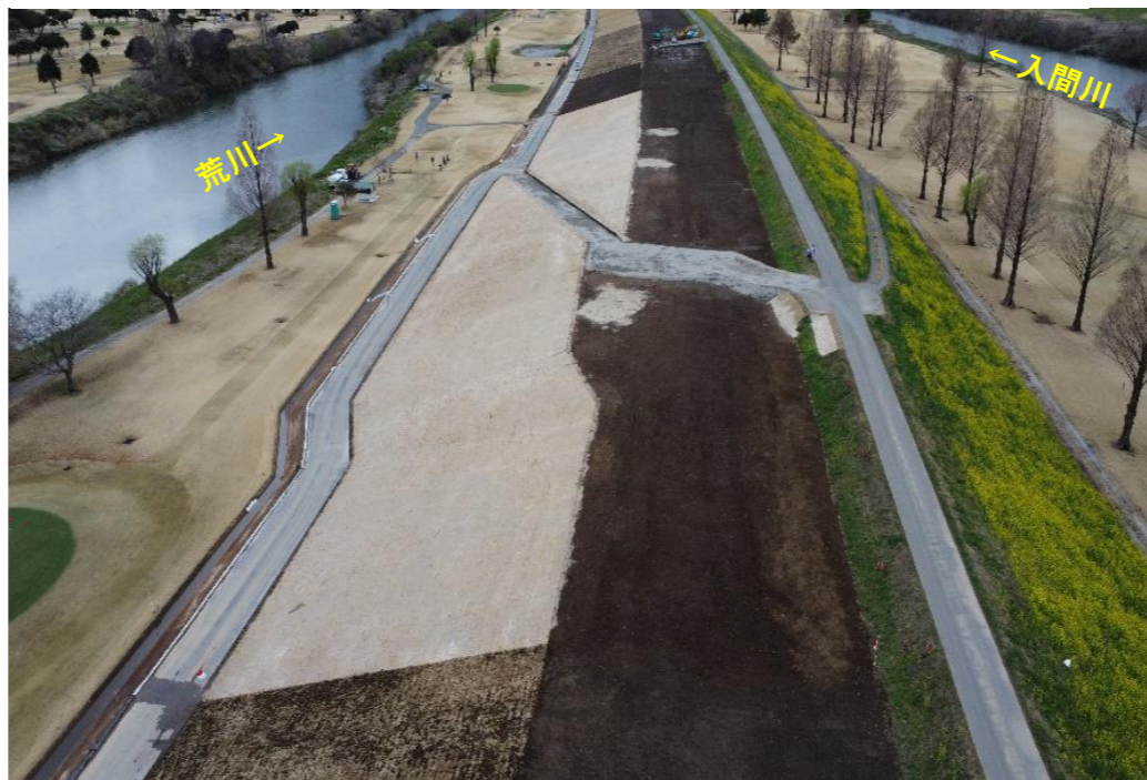
完成（上流側から下流側へ撮影）
