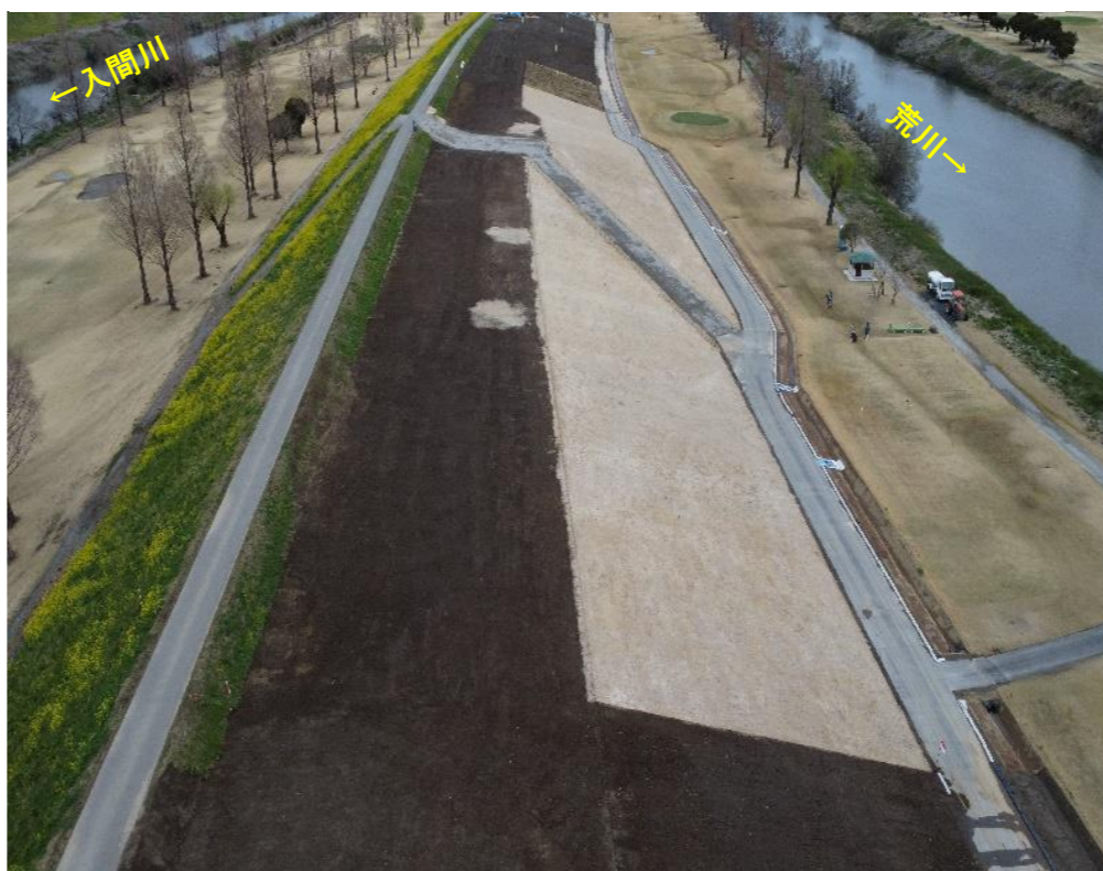
完成（下流側から上流側へ撮影）
